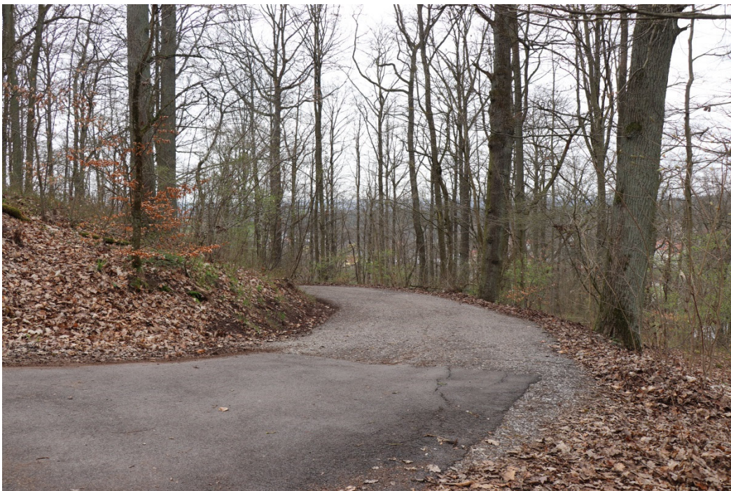
Abb. 51 „Nahtstelle“ zwischen altem und neuem Wegverlauf
